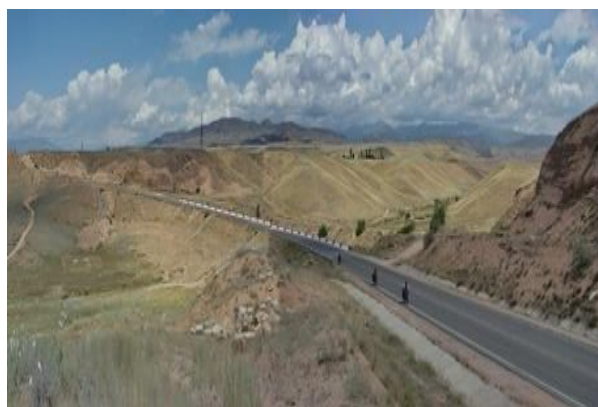
7.7. На трассе Ош - Бишкек
