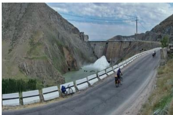
1.3. Плотина Кировского водохранилища
