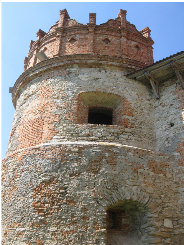
Фото 38. Башня в Староконстантинове.
