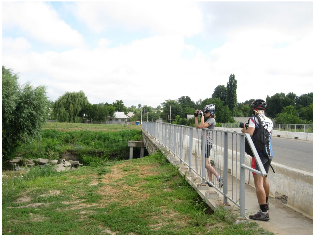
Фото 3.1 – На въезде в Балту.
